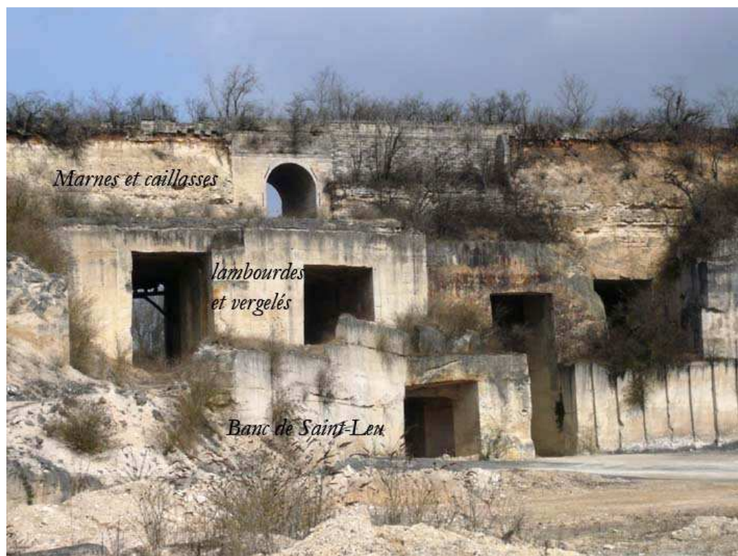
Photo 4. Au même endroit : l'ancien front de taille et les galeries sous le chemin vicinal préservé.
